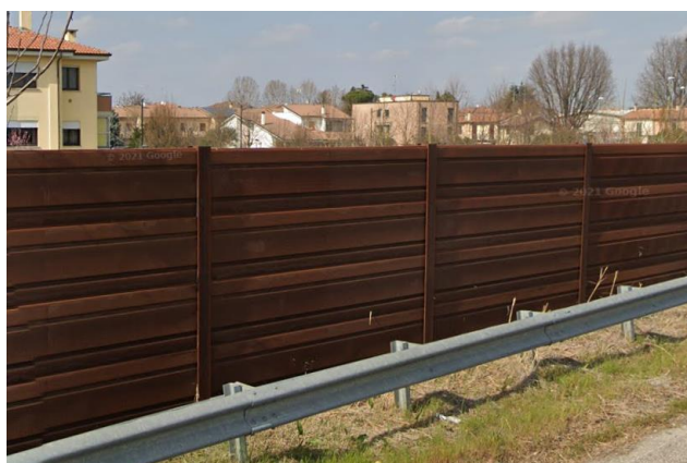
Figura 33 – Esempio di barriera fonoassorbente in corten
